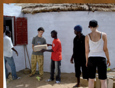
Construction d'une cuisine communautaire
