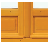
Vue extérieure, partie centrale et rejet d'eau
